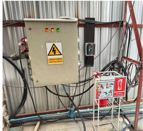
รูปที่ 28 ระบบจ่ายไฟ ป้ายเตือน “อันตรายจากไฟฟ้าช็อต” และ อุปกรณ์ดับเพลิง
