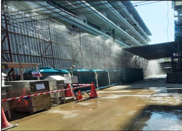
รูปที่ 13 ระบบสเปรย์น้ำลดฝุ่น
