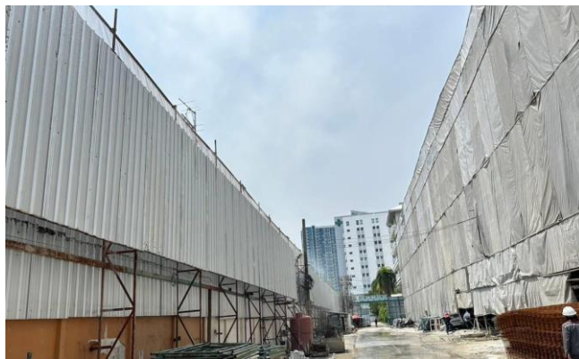
รูปที่ 3 รั้วเมทัลชีท และ mesh sheet รอบโครงการ
